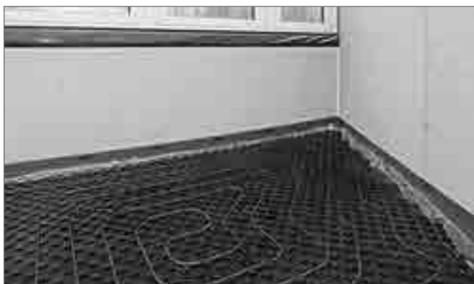
Рис. 16-22 Маты с фиксаторами Varionova с шагозвукоизоляцией 30-2 снизу
