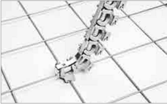
Рис. 16-61 Установить штангу с магазином поворотных клипс
