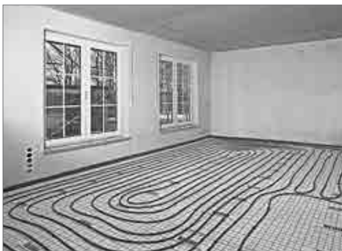
Рис. 16-33 Система крепления труб с помощью гарпун-скоб
