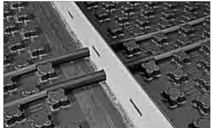
Рис. 16-29 Полосы примыкания и профиль деформационного шва
