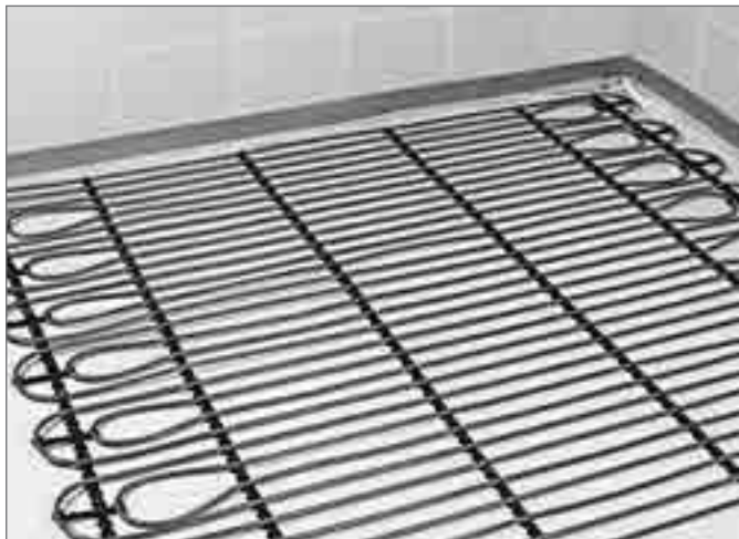
Рис. 16-67 Напольная фиксирующая шина для «мокрого» способа монтажа
