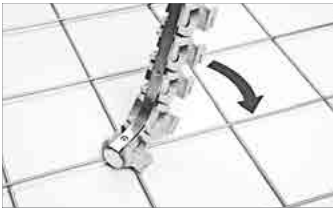
Рис. 16-62 Закрепить поворотную клипсу вращательным движением
