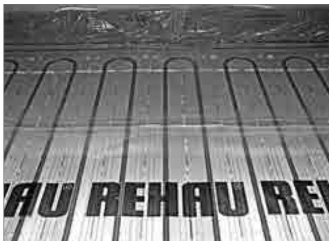
Рис. 17-1 Система укладки труб на теплоизоляционных матах TS-14
